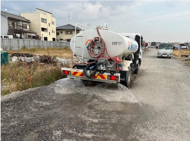
⑦ 散水作業状況
