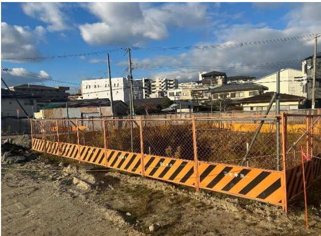
⑨ 沈砂池設置状況
