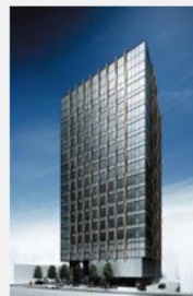
住友不動産 大崎ツインビル 西館
