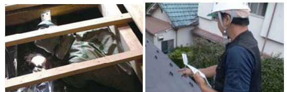
<床下、屋根調査>
