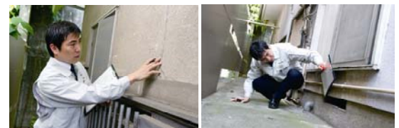
<外壁、基礎調査>
