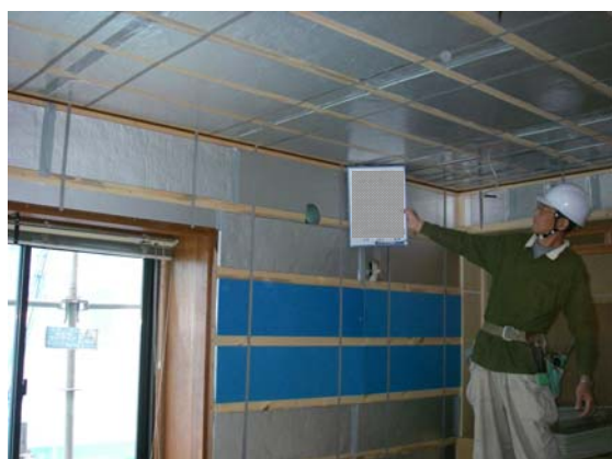
＜壁、天井の断熱施工イメージ＞
