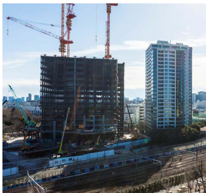
＜全体竣工に向けて工事が進む 平成27年2月現在＞ （左：業務棟 右：分譲住宅棟）
