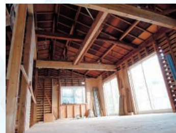
施工中(構造躯体まで解体した状態)
