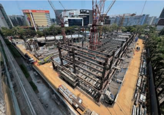
工事状況（2025年5月）
