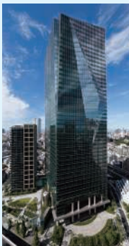
住友不動産 六本木グランドタワー
