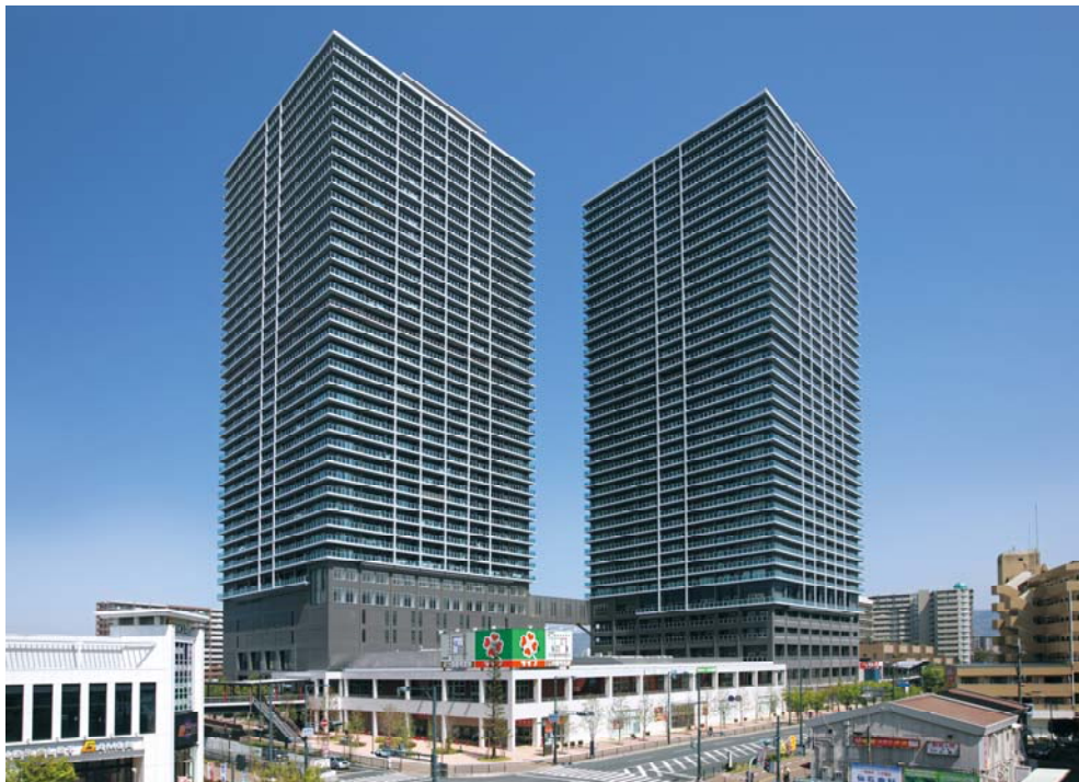
「メガシティタワーズ」外観（左側：西棟 右側：東棟）
