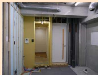
施工に関するお客様の疑問にわかりやすくお応えするため、スケルトン状態から配線・配管処理、断熱材、ボード貼りといった、具体的な工事の内容がご覧いただけます。
