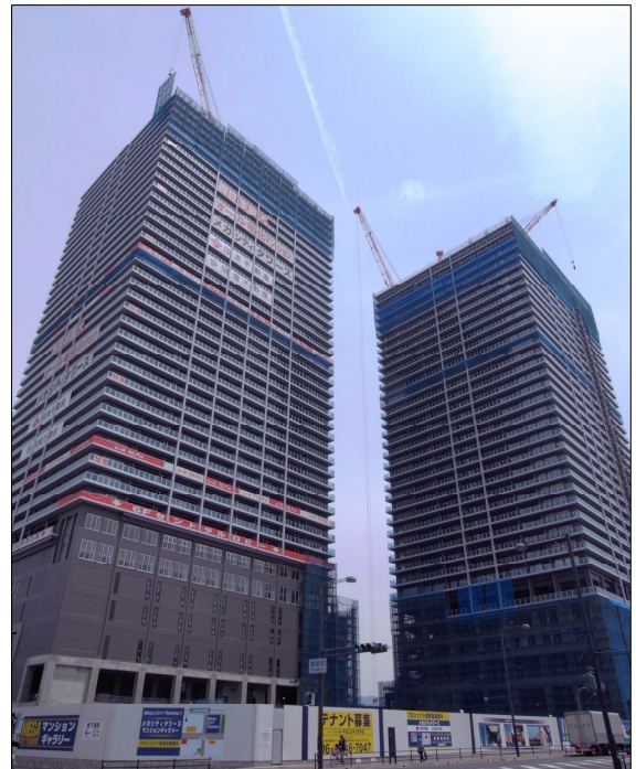
<平成 22 年 4 月下旬の施工状況> 左側が THE WEST 棟（40 階まで上棟）
