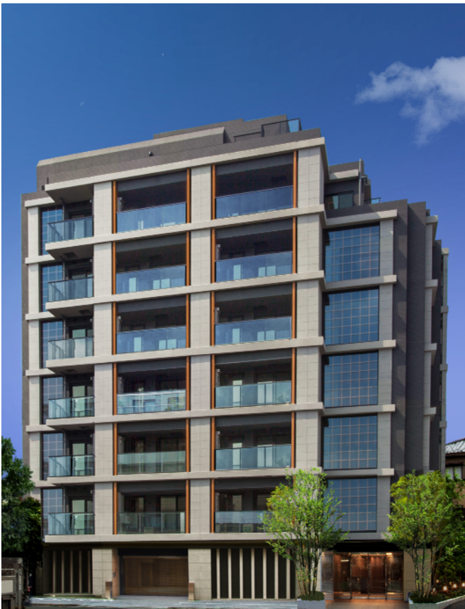
<建物外観写真>
