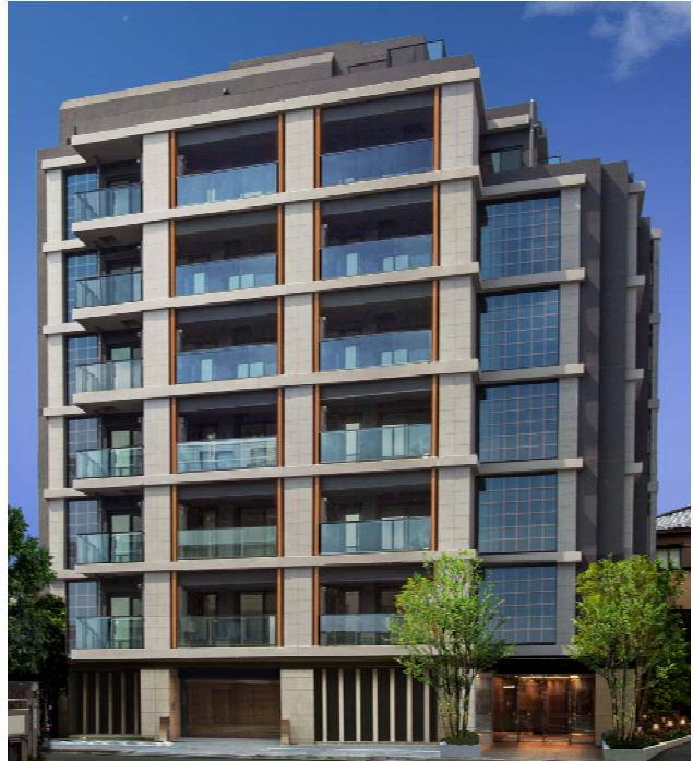
<建物外観写真>
