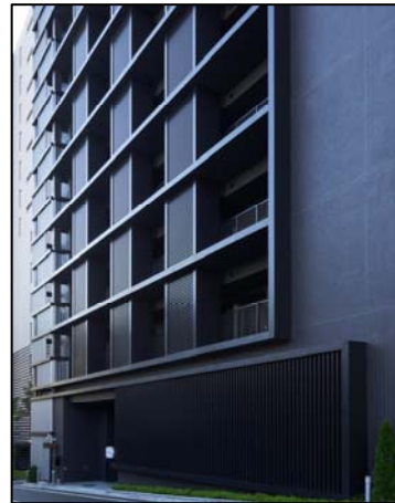
<施工イメージ>
