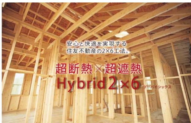
弊社はこれまで、寒さが厳しく高気密、高断熱の需要が高い札幌エリアにおいて 2×6 工法を標準仕様としておりましたが、札幌以外の地域でも、より高気密、より高断熱、さらなる耐震性の強化を求めるお客様向けに 2×6 工法を商品ラインナップに加えました。
