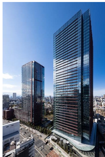
左: 住友不動産東京三田サウスタワー 右: 住友不動産東京三田ガーデンタワー
