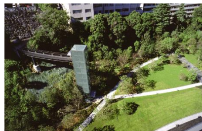
東京三田サウスタワーの緑地
