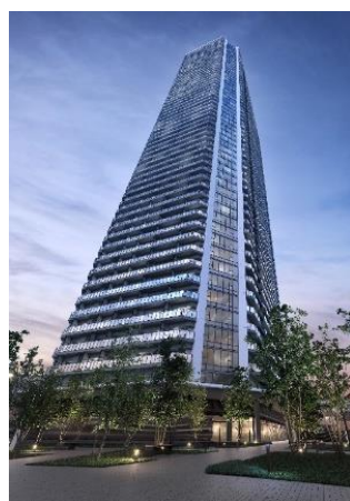
グランドシティタワー月島 完成イメージパース (2026年4月竣工予定)
