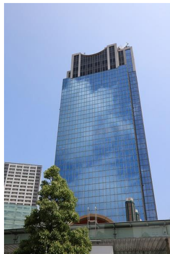
川崎駅前タワー・リパーク外観
