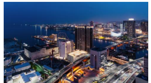
建設地付近より現場を撮影(2023年4月)
