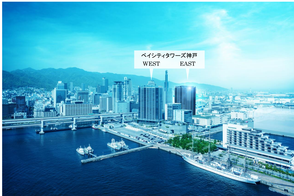
<ベイシティタワーズ神戸WEST/EAST 外観イメージパース>
