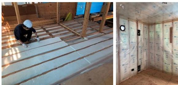
断熱材を床、壁、天井に施工している様子
