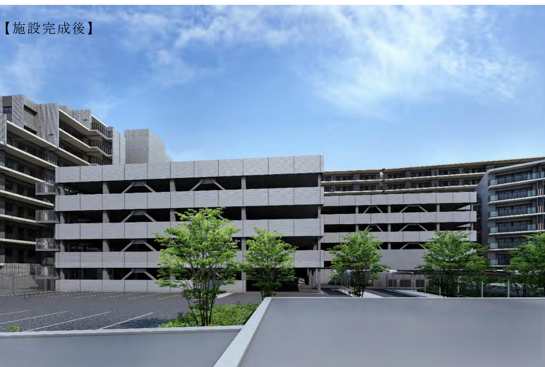
図 12-10-7 事業地北側道路からの景観
