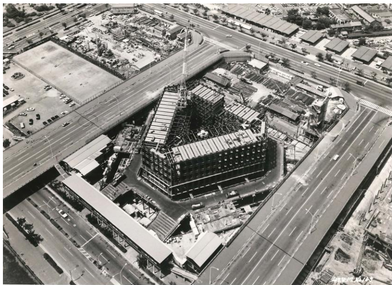
<建設中(昭和47年8月20日)>
