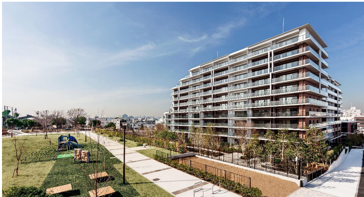
<外観竣工写真>
