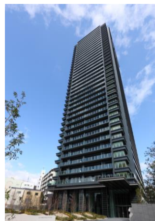
シティタワー大阪福島 (2009年3月竣工)
