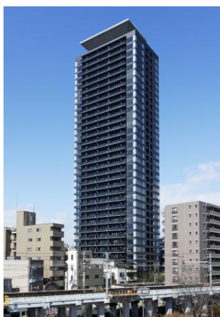
シティタワー天王寺真田山 (2012年3月竣工)
