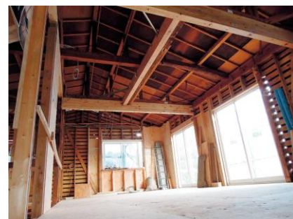
<施工中(構造躯体まで解体した状態)>
