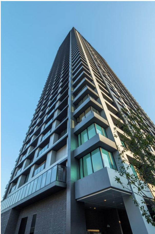
<シティタワー梅田東外観>
