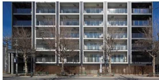
“幹線道路面”では、マンションのファサードを、一定の住戸スパンで縦ラインと配色により分節し、建物をスマートに見せることで威圧感を抑える工夫を取り入れています。
