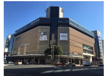
<住友不動産京都ビル 外観>
