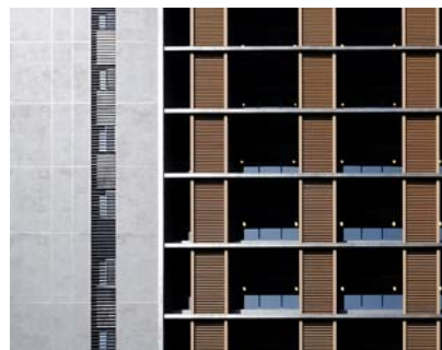
< S-マルチコア施工例 >
