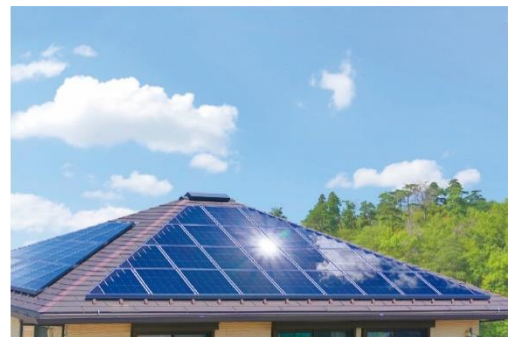
太陽光パネル設置の屋根
