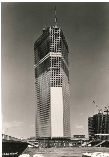
<建設中(昭和48年3月14日)>
