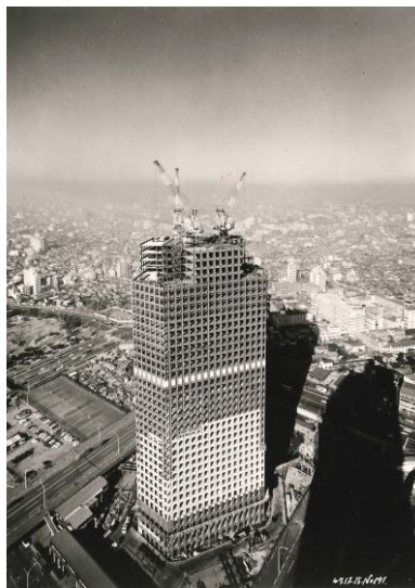
<建設中(昭和47年12月14日)>
