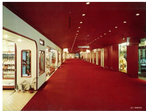
<竣工時・地下商店街>
