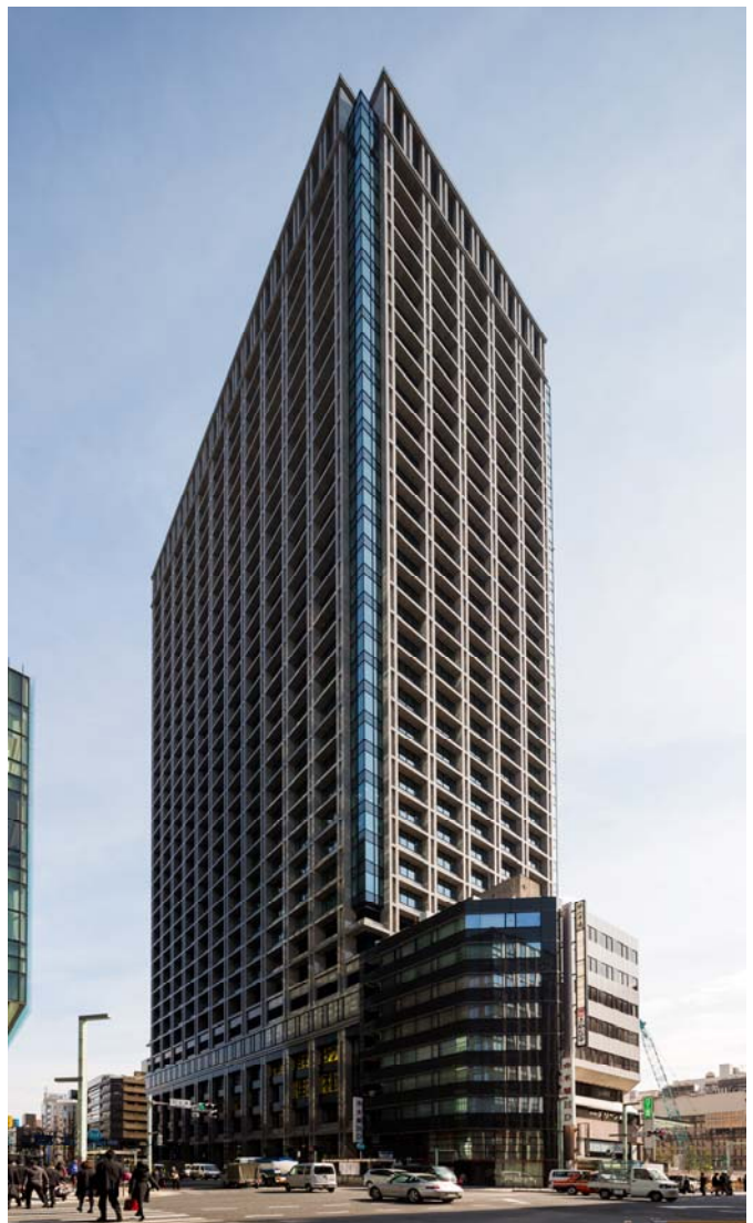
<日本橋交差点から見た建物全景>
