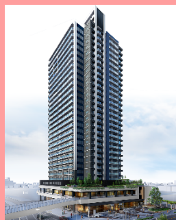
シティタワー所沢クラッシィ
