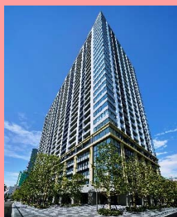
シティタワー大井町
